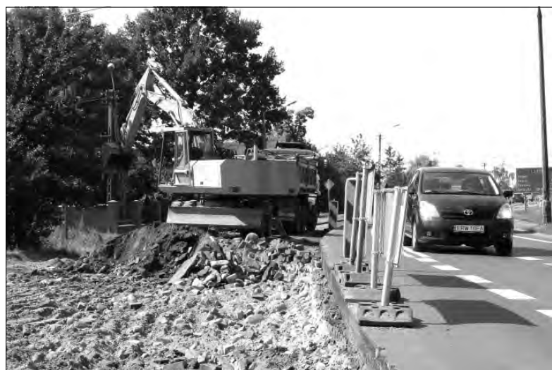
Roboty drogowe przy przebudowie drogi krajowej nr 2 (ulicy Poznańskiej) w Łowiczu powoli nabierają tempa. Aktualnie wybierana jest stara podbudowa na części prawego pasa jezdni (jadąc od strony Zdun) w okolicach ulicy Płockiej. Podczas prac obowiązują ograniczenia prędkości oraz ruch po wydzielonych kolorem żółtym pasach ruchu. Pomimo robót ruch na tym odcinku odbywa się w obydwóch kierunkach jednocześnie.
