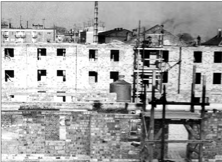
Osiedle Reymonta - tak powstawało.
