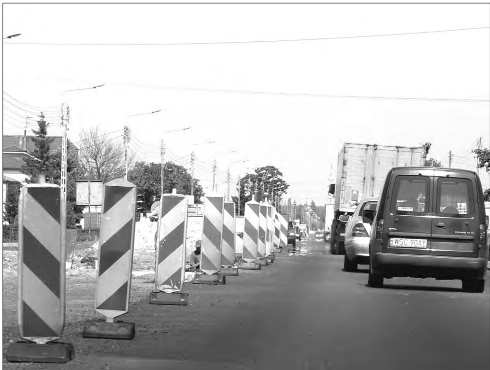
Dopiero w październiku ma zakończyć się remont niedużego mostu w ciągu drogi krajowej nr 14 pomiędzy Łowiczem a Jamnem (na wysokości ogródków działkowych przy ul. Łódzkiej). Do tego czasu w tym miejscu obowiązywać ma ruch wahadłowy, którym w ciągu dnia sterują pracownicy firmy remontującej most, a po godzinach pracy przenośna sygnalizacja świetlna. (mak)
