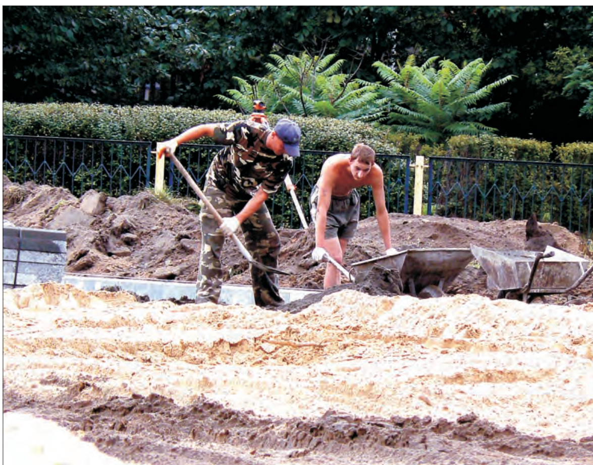
Pracownicy gostynińskiej firmy wykorytowali teren boiska i układają krawężniki wokół jego płyty.
