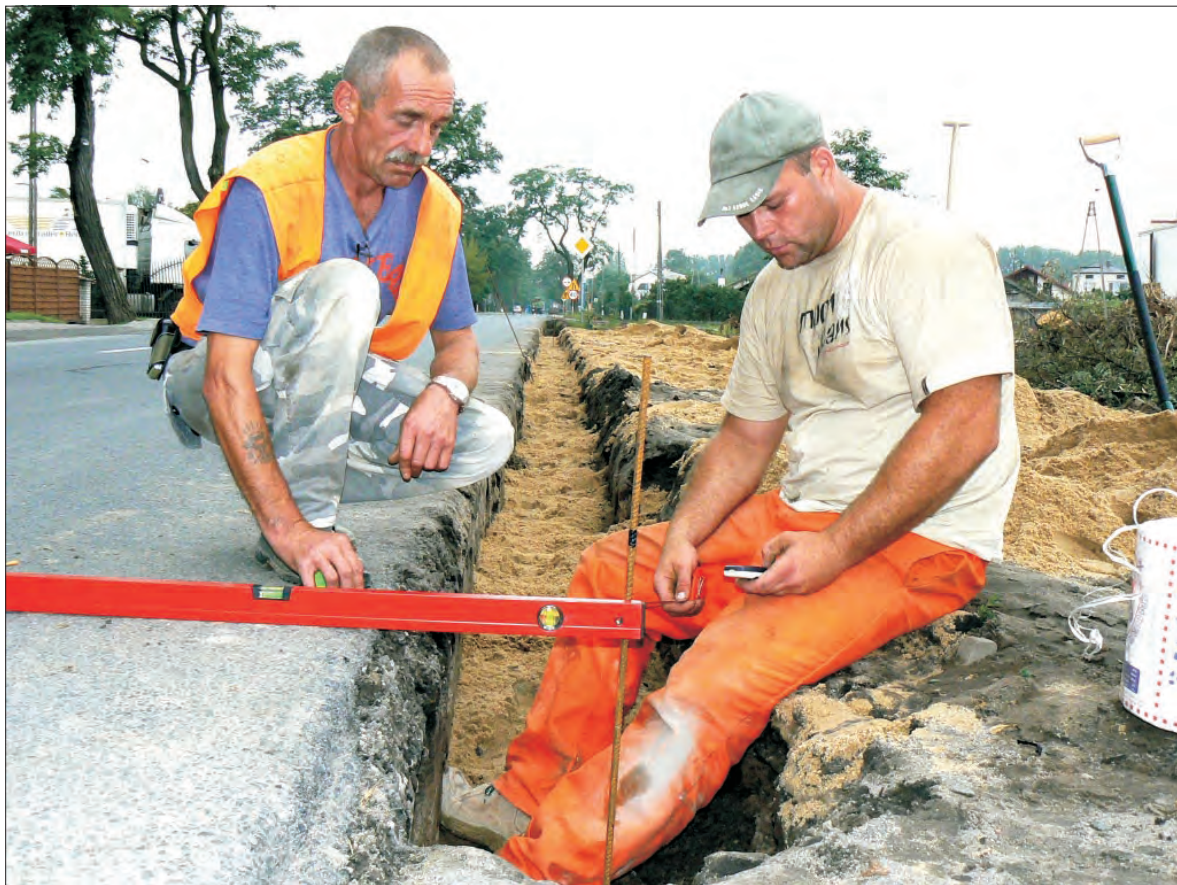
Po usunięciu kilku akacji pracownicy A.T.Z. rozpoczęli w poniedziałek 13 sierpnia prace ziemne.
