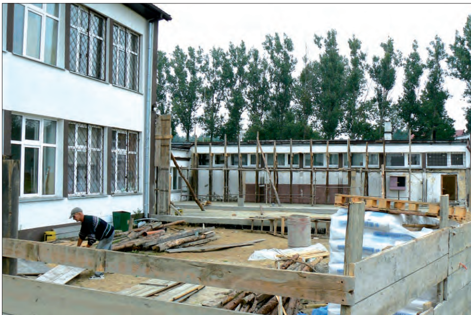
Prace w Domaniewicach wznowione będą nieprędko. W ubiegły piątek, 10 sierpnia, spotkaliśmy tam pracowników z Urzędu Gminy, których skierowano tu, aby ogrodzić i zabezpieczyć plac budowy.
