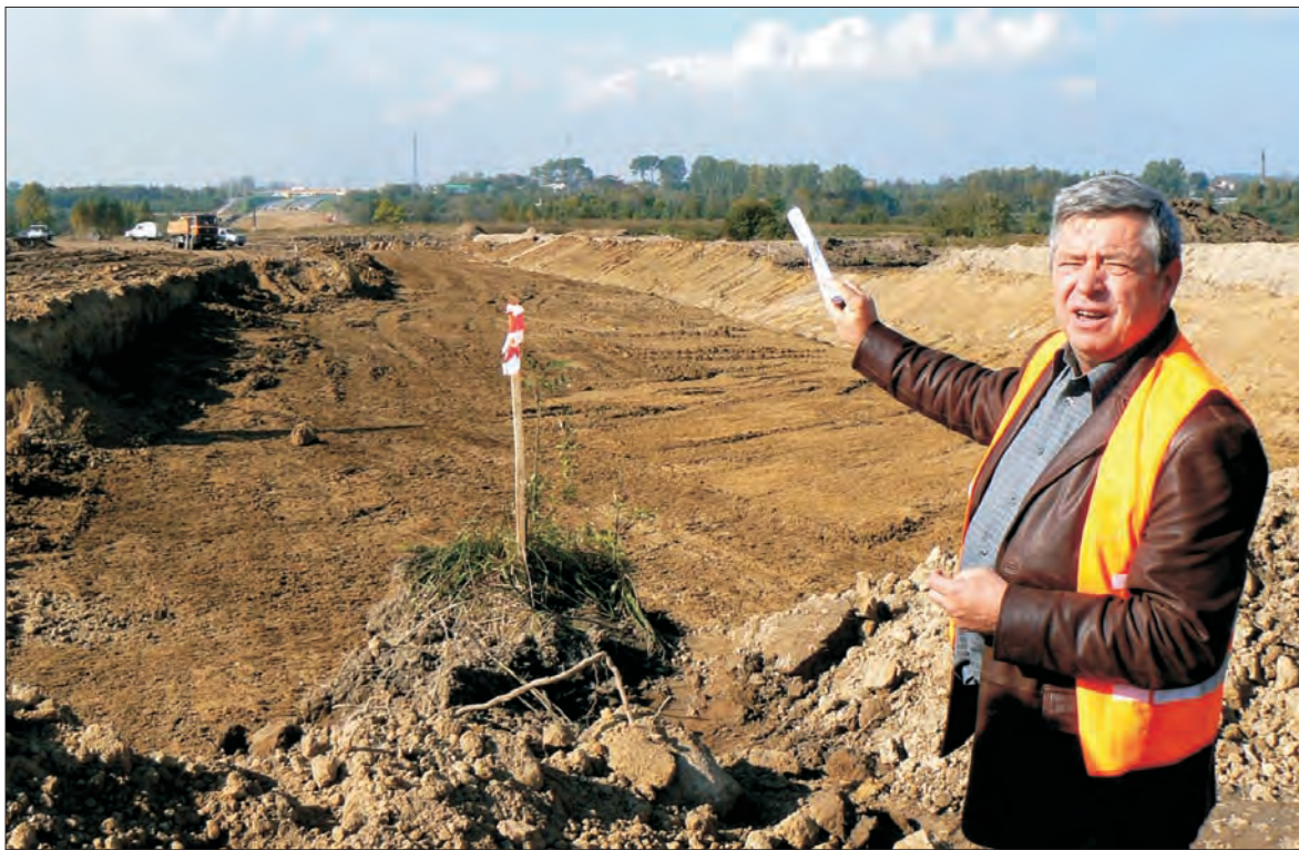
Do października przyszłego roku tutaj będzie rządził ten człowiek - Andrzej Nyk, dyrektor kontraktu, przedstawiciel wykonawcy Kirchner Polska.
