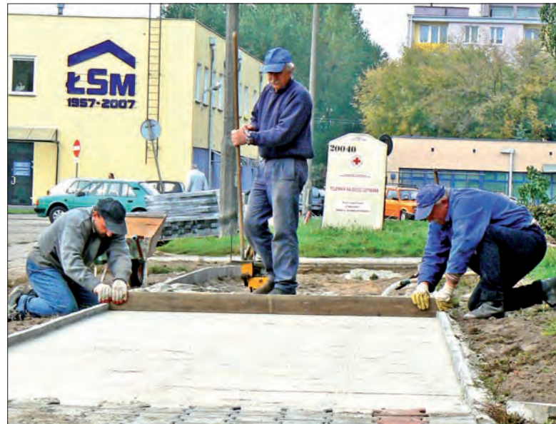
Po zakończeniu robót z parkingiem w szczytach bloków 8 i 9 na Starzyńskiego, roboty zostały przeniesione na budowę chodnika i związane z tym powiększenie parkingu przy blokach 2 i 3 na tym osiedlu. Inwestycję tę realizują wspólnie ŁSM i miasto.
