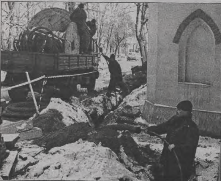
We wtorek, 2 lutego rozpoczęły się prace w ramach drugiego etapu modernizacji oświetlenia i sieci zasilającej posesje w Alei Sienkiewicza w Łowiczu. Realizacja inwestycji podzielona została pomiędzy Zakład Energetyczny i miasto. Na zlecenie tego pierwszego kabel zasilający przyłącza wraz ze skrzynkami rozdzielczymi doprowadzającymi energię do posesji wykonuje skiemiwicka firma EI - In. Na zlecenie miasta prace przy wykonaniu zasilania oświetlenia ulicznego z zamontowaniem w Al. Sienkiewicza stylizowanych lamp oświetleniowych wykonuje łowicki lwtech. Roboty mają zakończyć się do końca kwietnia, jeżeli będą sprzyjające warunki atmosferyczne. (tb)
