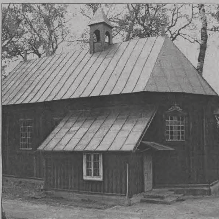
Jedyna budowla, która pamięta czasy Józefa Chelmońskiego w jego rodzinnych Boczkach - drewniany kościółek aż prosi się o remont, zwłaszcza dach pokryty zamiast gontem - blachą cynkową.
