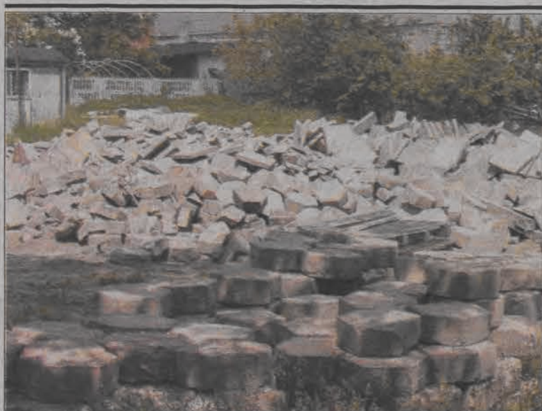
Betonowe płyty z chodników, na których ułożona jest kostka wykorzystane zostaną m. in. do utwardzenia parkingu przy budynku urzędu gminy.
