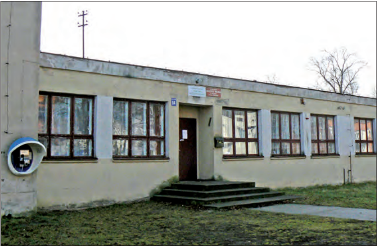
Budynek Domu Ludowego w Boczkach jest już własnością gminy. Jakie prace trzeba będzie w nim przeprowadzić, zdecyduje Rada Gminy.
