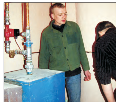
Na nowy piec wydzielone zostało specjalne pomieszczenie w siedzibie stowarzyszenia „Nadzieja”.
