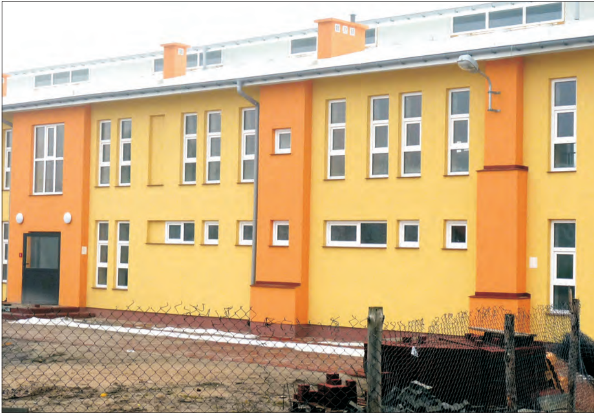
Sala przy szkole w Błędowie jest na ukończeniu.
