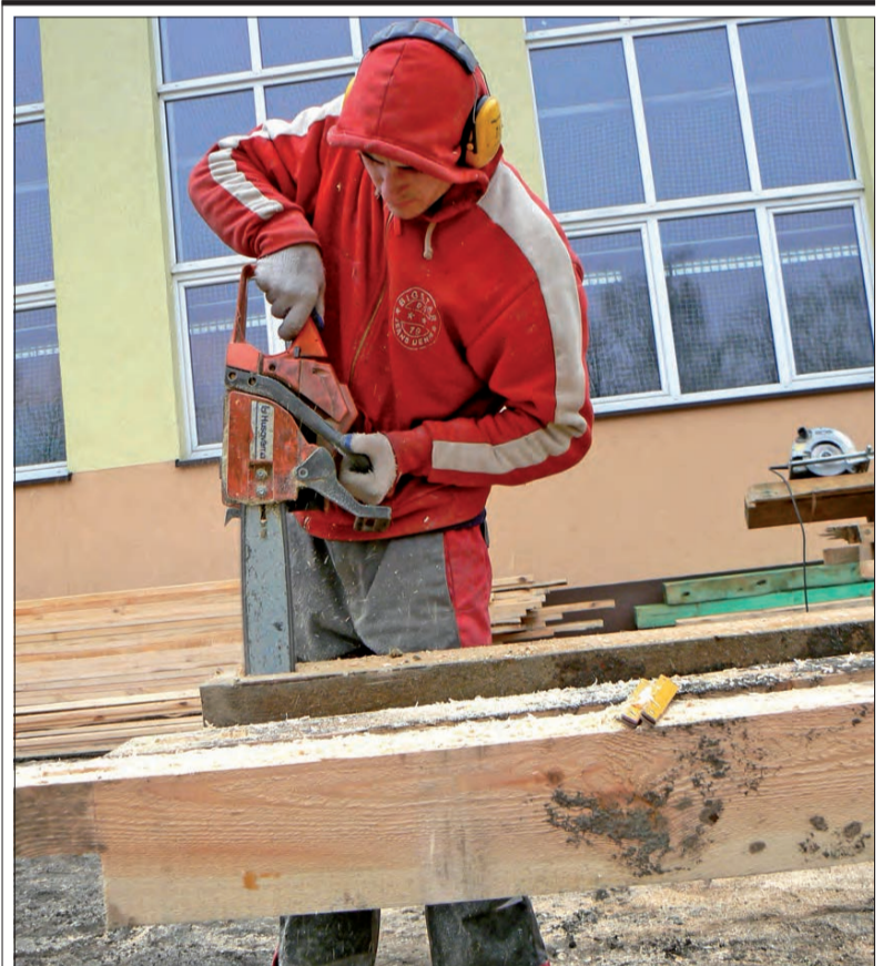
Drewniane elementy konstrukcji są przygotowywane do osadzenia na fundamentach.
