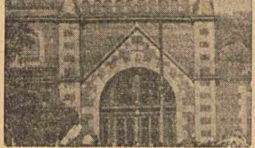
Fragment głównego wejścia dworca kolejowego w Gdańsku.
