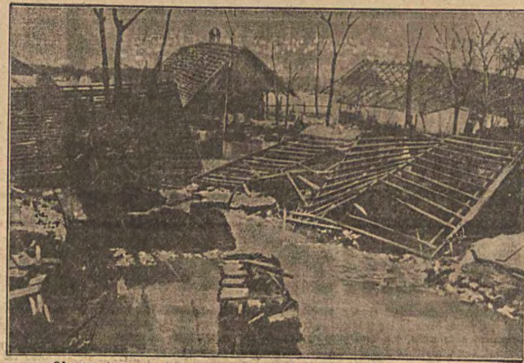
Obraz zniszczenia jaki spowodowały wylewy w południowych Węgrzech.
