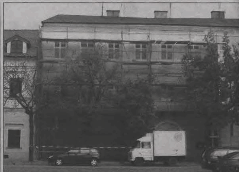
Z tego, co dzieje się na elewacji kamienicy przy Starym Rynku niewiele widać, ale prace remontowe mają sprawić, że nie będzie ona odstawać urodą od swojej sąsiadki.
