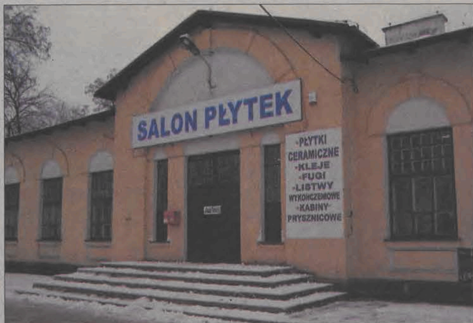
Dewastacja budynku dawnego dworca PKP Przedmieście nie będzie już postępowała - a to za sprawą uruchomienia w nim sklepu z płytkami.
