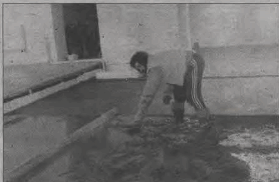
Wylewanie betonowej posadzki w kościele. Luty 2001.
