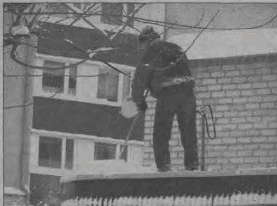
Kiosk na Dąbrowskiego - co dwie godziny trzeba było wejść na dach i usunąć z niego śnieg.
