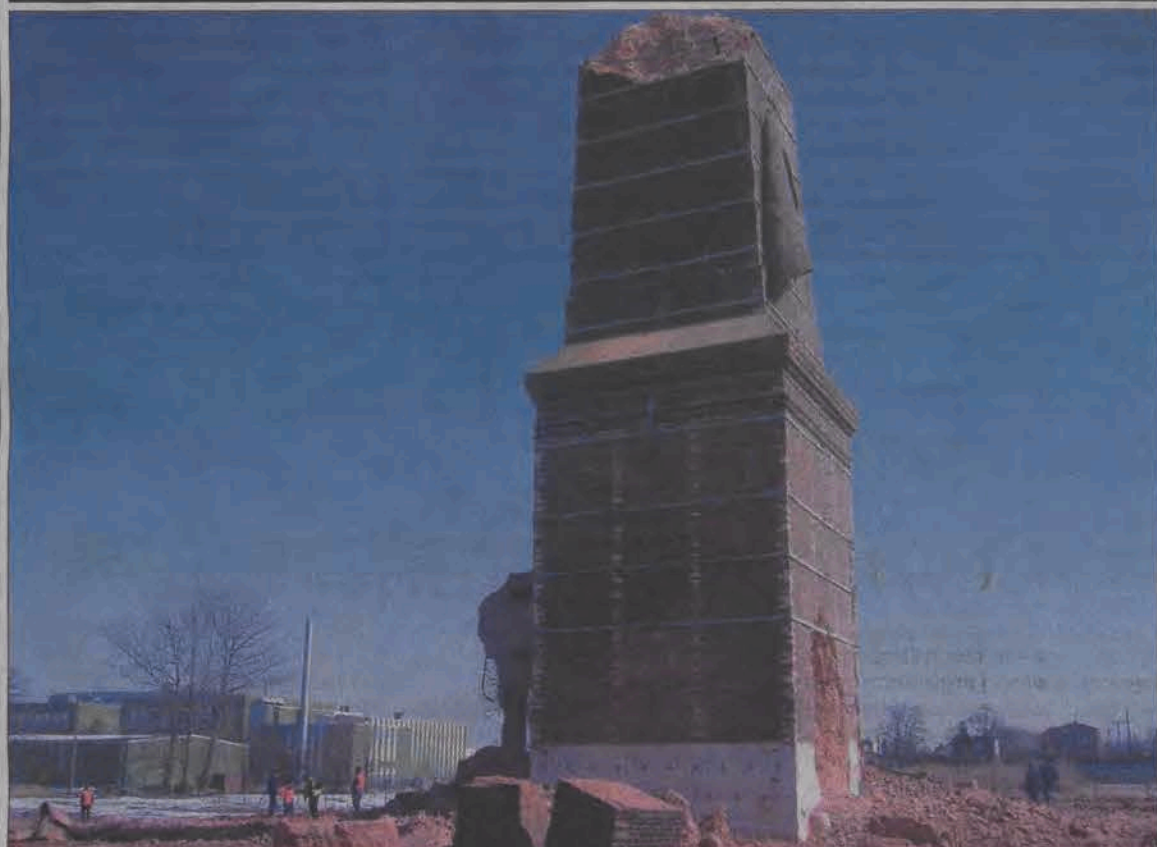
Czasy się zmieniają... Na pierwszym planie pozostałości wyburzanego komina, w tle po lewej stronie nowe budynki fabryki Altana Pharma.
