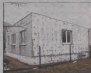
Nowy budynek stanął tuż za muszlą koncertową, mieści m.in. kotłownię i garderoby.
