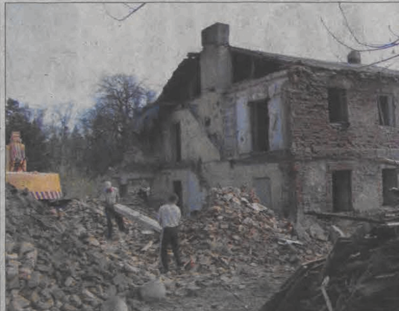
Firma Hatrex z Gąbina rozbiera stary budynek przy ul. Fabrycznej. Gruzu z rozbiórki może być za mało, aby poprawić stan kilku dróg w gminie.
