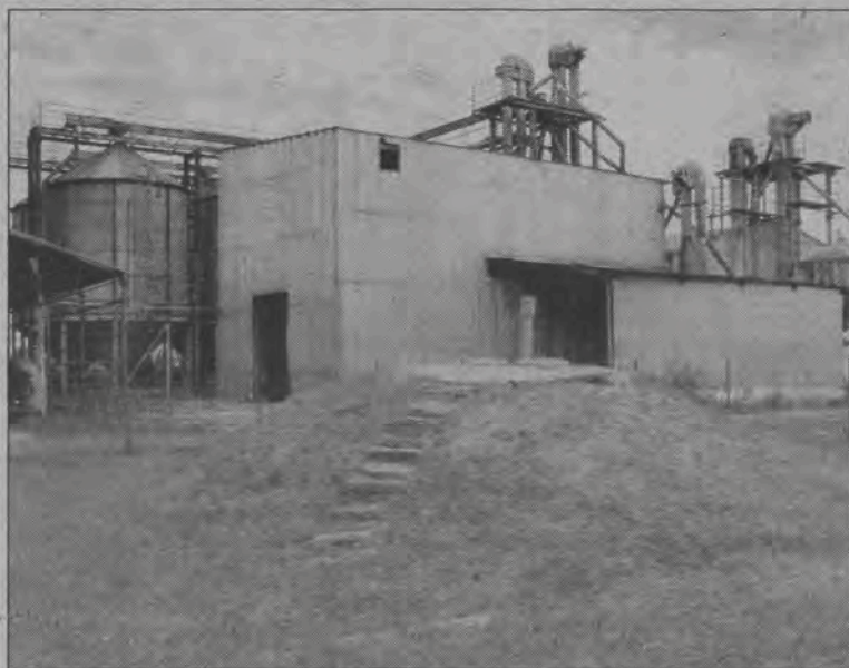
Na pierwszym planie studnia gminnego ujęcia wody na terenie spółdzielni.
