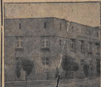
Budynek Ubezpieczalni Społecznej w Radomsku przy ul. Limanowskiego 47, mieszczący biura, aptekę, zakłady lecznicze i ambulatoria
