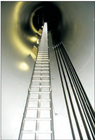
A tak wygląda od wewnątrz wiatrak o mocy 2 MW.
