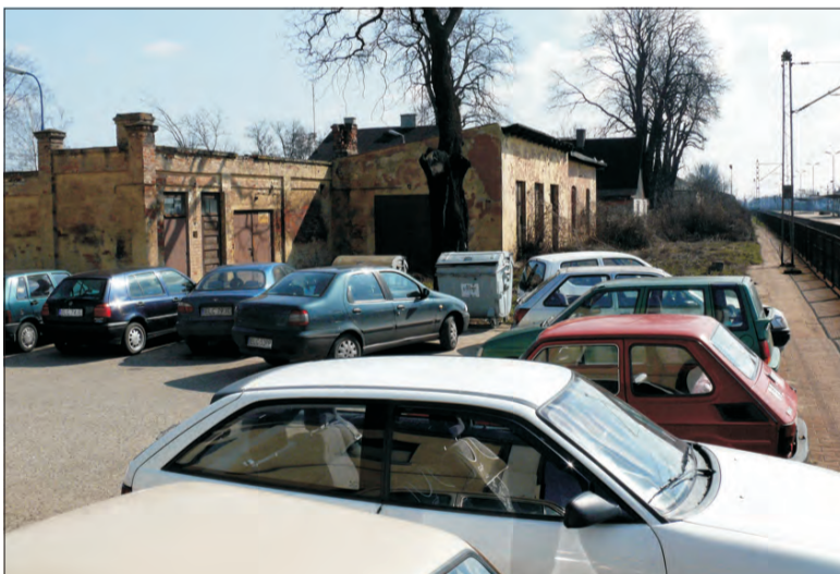
Chodzi o te nieruchomości: po ich wyburzeniu parking pomieściłby samochód każdego pasażera.
