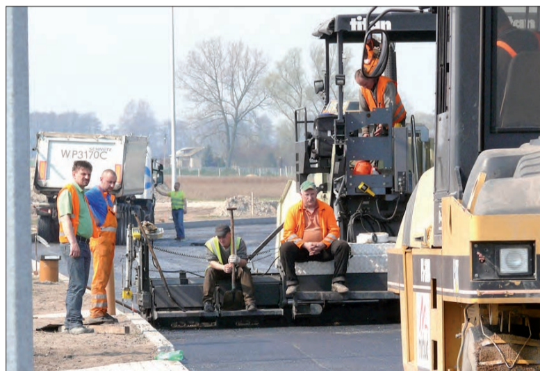
Chwila przerwy w oczekiwaniu na nową dostawę asfaltu. Prace na ulicy Uchanka.
