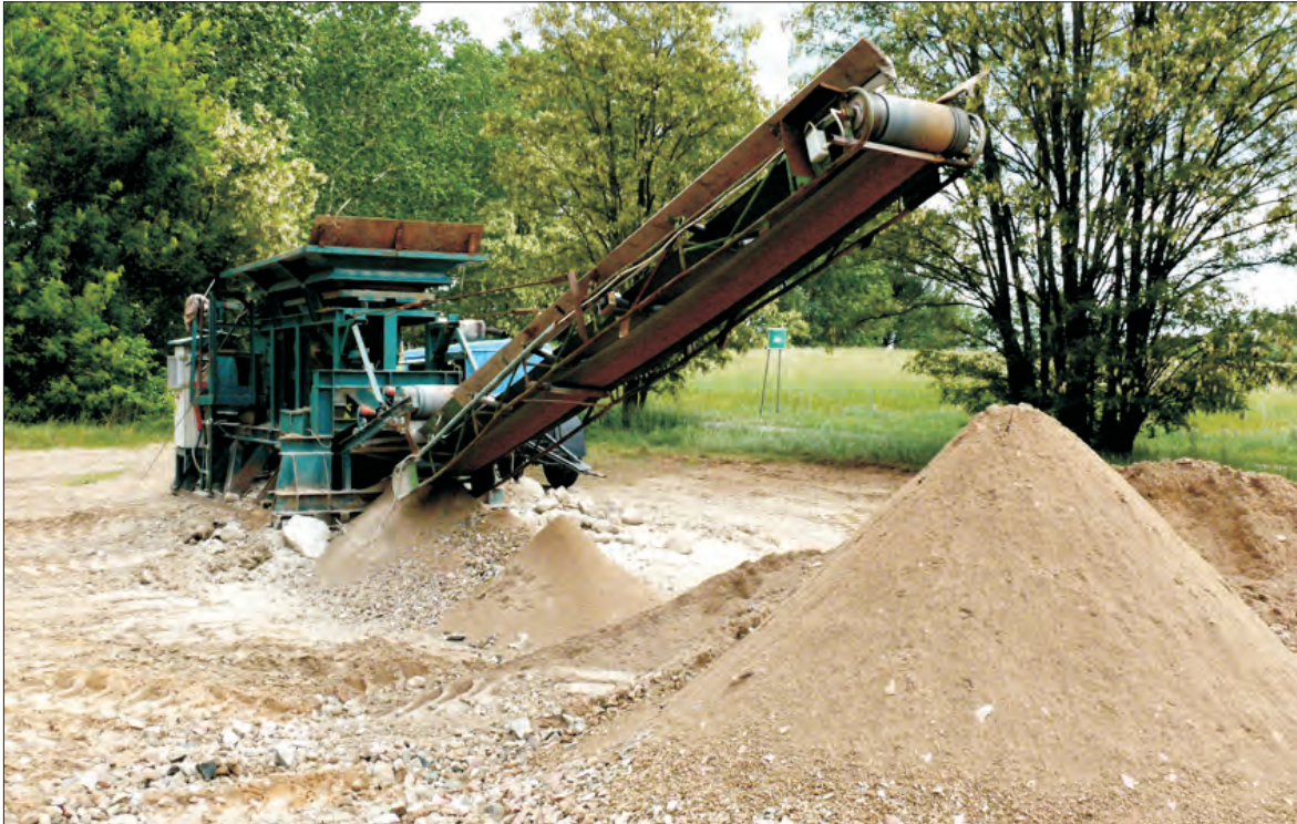
Zanim rozpoczyna się prace na drogach maszyna ta musi rozdrobnić zwieziony materiał pozyskany z drogi krajowej.
