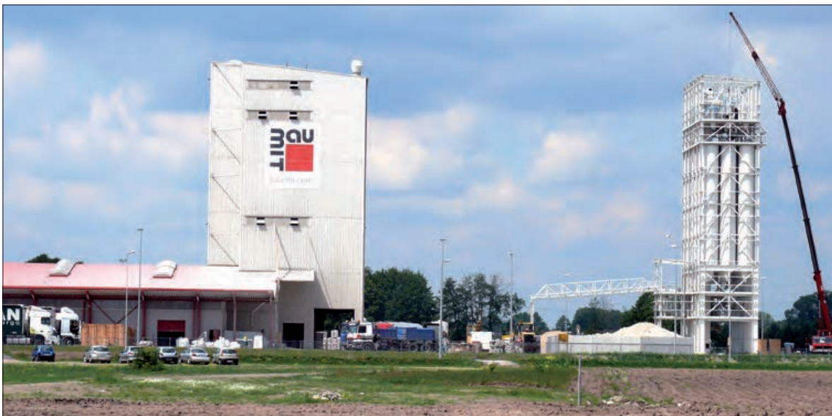
Silosy umieszczone w nowej wieży, widocznej po prawej stronie, niedługo zostaną obudowane.
