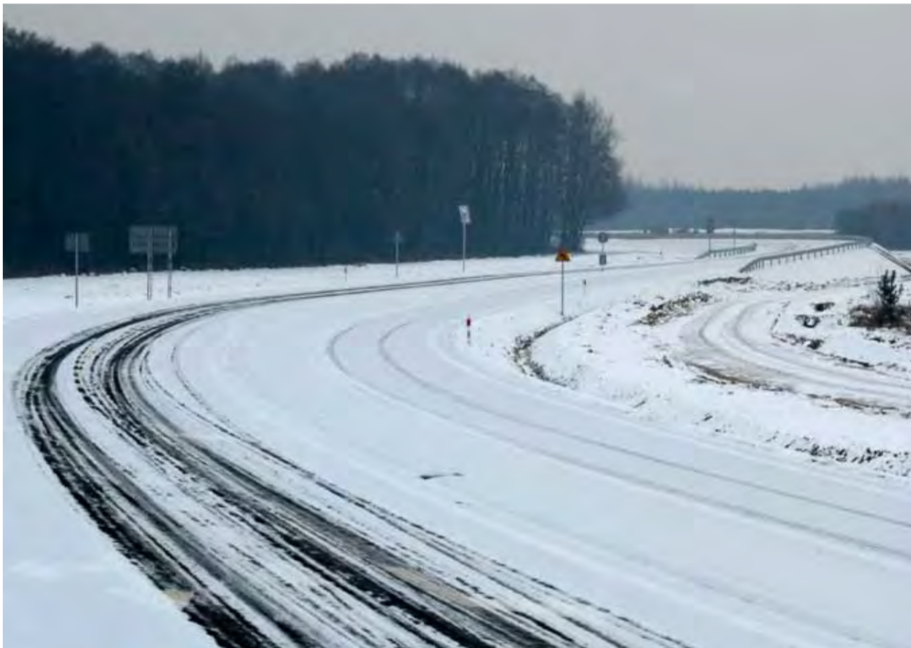
Nowy odcinek siedemdziesiątki nie jest wykorzystywany. Choć prace przy jego budowie już dawno się zakończyły, kierowcy czekają na dopuszczenie go do ruchu. Widok od strony Łowicza.
