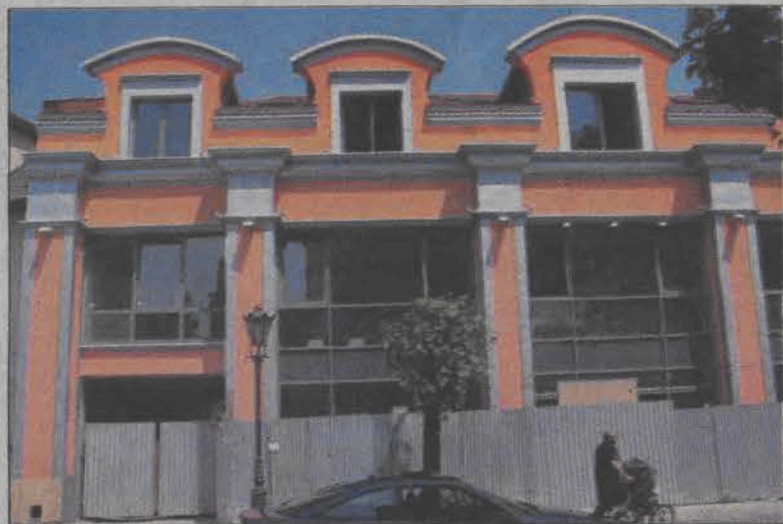
Pierwszy sklep w Galerii Łowickiej ruszył na Wielkanoc. Obecnie trwają prace wykończeniowe w drugiej części budynku - od ul. Długiej. Elewacja od strony ulicy Stanisławskiego utrzymana jest w stylu klasycystycznym i historycznym charakterze, zaś fasada od ulicy Długiej przybrała nowoczesny styl; dominującym budulcem jest tu metal oraz szkło a kolorami szary i pomarańczowy. (eb)
