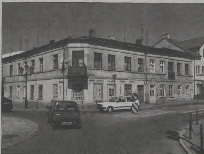
Upór dyrektora, upór właścicieli. Rezultat: w centralnym miejscu miasta zaniedbany, brzydki budynek.
