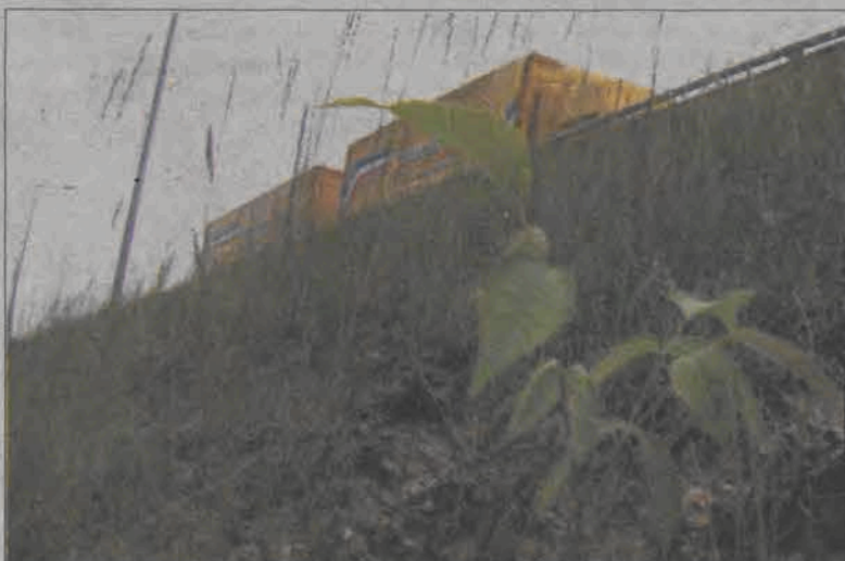
Zanim posadzone na wiadukcie drzewka i krzewy wyrosną, miną lata, a nawet wtedy ochronę przed hałasem zapewnią raczej iluzoryczną.
