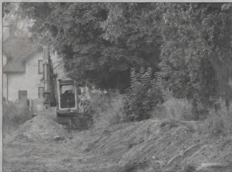
Prace na Kaliskiej idą pełną parą, nie zaszkodzą one drzewom rosnącym przy drodze.
