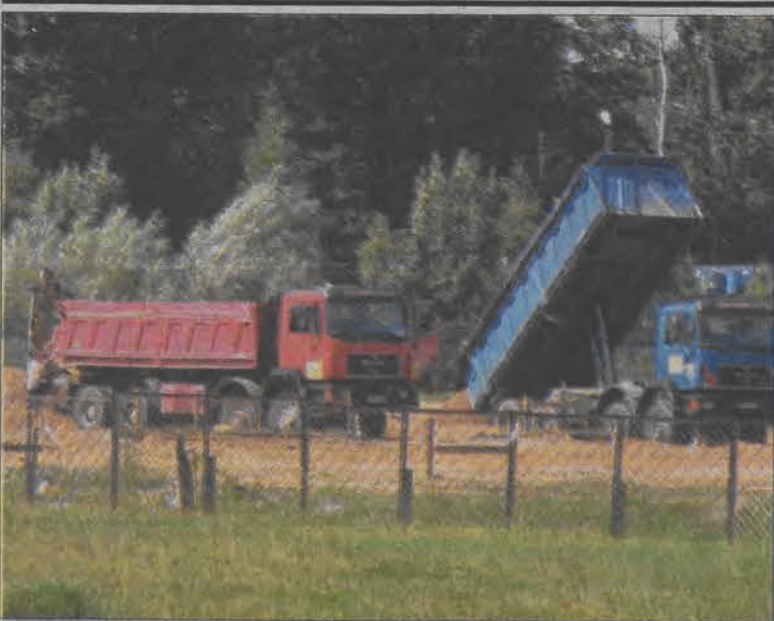
Prace przy budowie marketu Kaufland.
