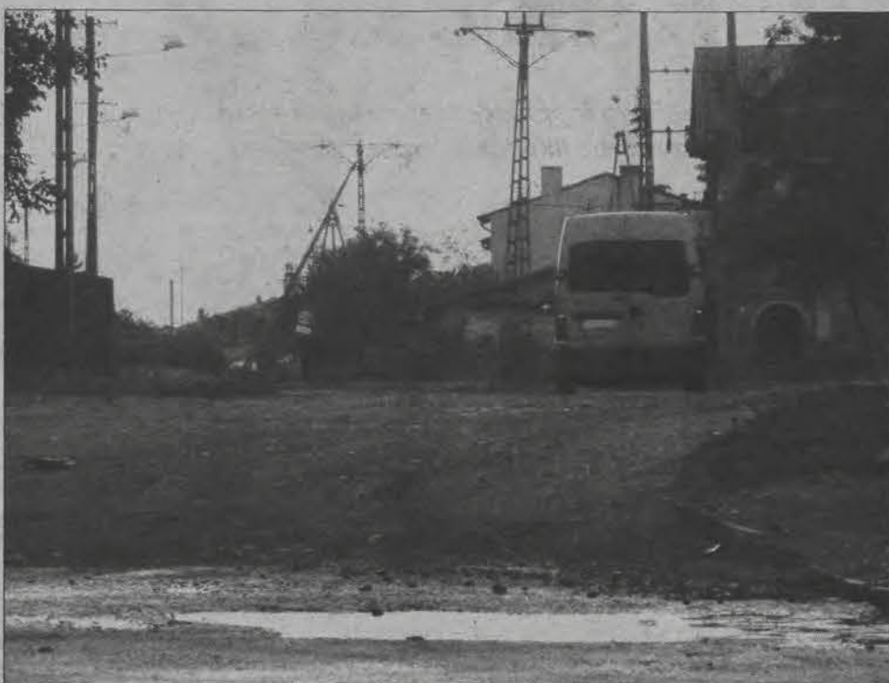
Ul. Jordana od strony wjazdu z ul. Armii Krajowej - dziura w zjeździe, doły na całej długości, ratusz obiecuje, że na jesieni ma się tu pojawić kostka.
