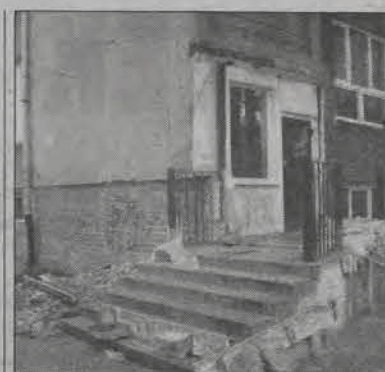
Prace remontowe w Gimnazjum nr 1.
