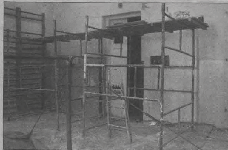
Remont małej sali gimnastycznej w ZSP 1 trwa.
