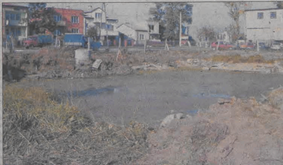
Sucha jesień sprzyja pracom przy osuszaniu basenu przeciwpożarowego. Jeśli nie będzie technicznych przeszkód, w przyszłości powstanie tu parking.
