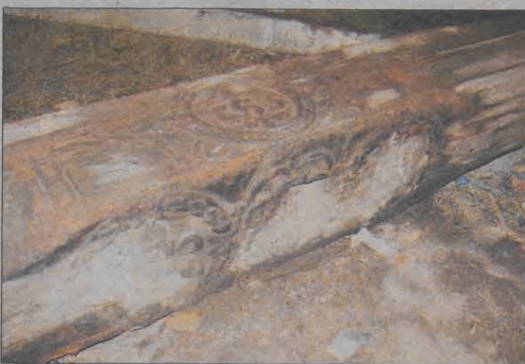
Mimo upływu blisko czterech wieków belka zachowała się bardzo dobrze.
