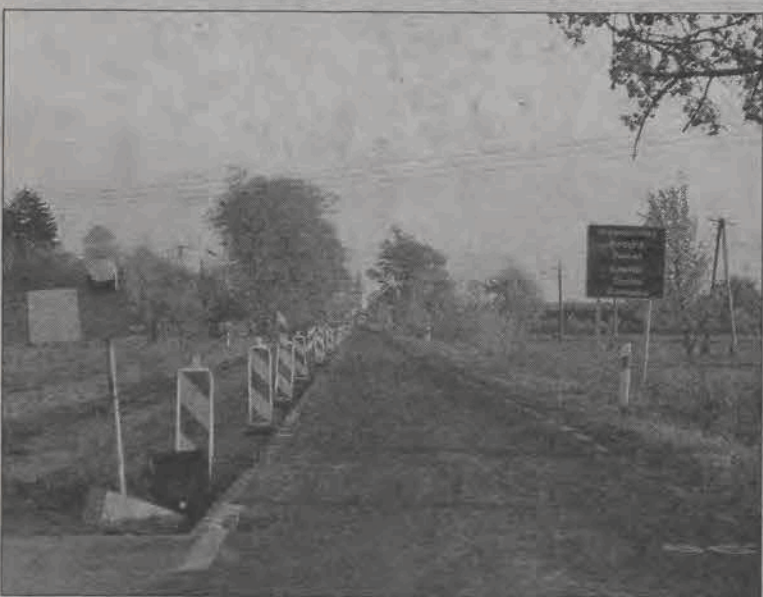
Wahadłowo pod Kiernozią. W ubiegłym tygodniu rozpoczęła się przebudowa drogi wojewódzkiej Łowicz - Sanniki pod Kiernozią. Prace prowadzone są na jednym pasie, ruch odbywa się wahadłowo. Dla zapewnienia bezpieczeństwa ustawiona została sygnalizacja świetlna. Prace rozpoczęto od zdjęcia warstwy asfaltowej, a następnie całkowitej wymiany podłoża do głębokości około 1 metra. Droga zostanie też poszerzona o pół metra (dotychczas miała 6 m), pobudowane zostaną chodniki. Prace mają być zakończone w tym roku.
