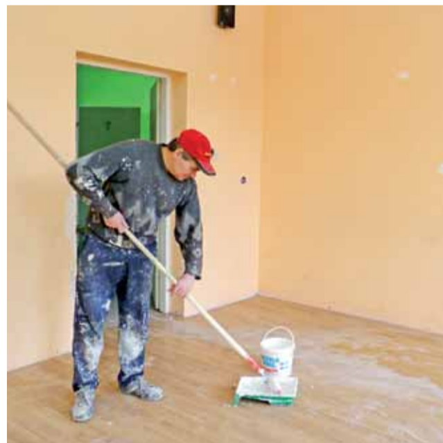
Pan Andrzej, konserwator w szkole wszystkie prace przy wyburzaniu ścianki działowej i powiększaniu szkolnej świetlicy wykonywał sam. W czwartek 30 stycznia zostało tylko malowanie.
