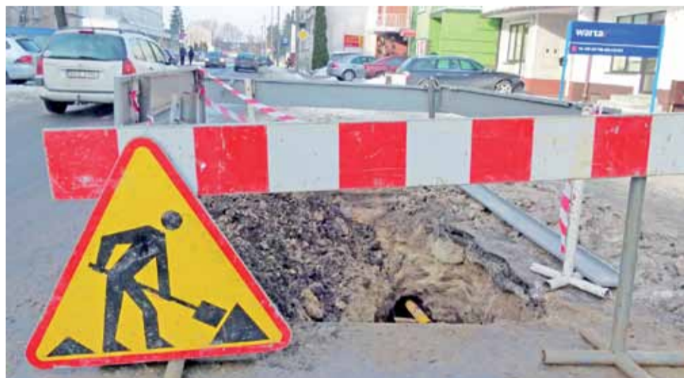
Awaria gazociągu została naprawiona następnego dnia w godzinach przedpołudniowych.
