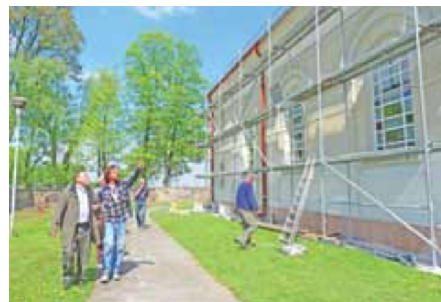
Trwają prace przy remoncie kościoła w Śleszynie z unijną dotacją. Proboszcz Waldemar Marczak wraz z kierownikiem budowy ustalają ostatnie szczegóły remontu. DOROTA GRABCZEWSKA
