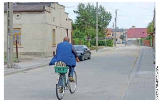
Ulica Kilińskiego jest już przejezdna. Wykonawca – firma Elvis – skróciła wykonanie zadania o ok. półtora miesiąca.
