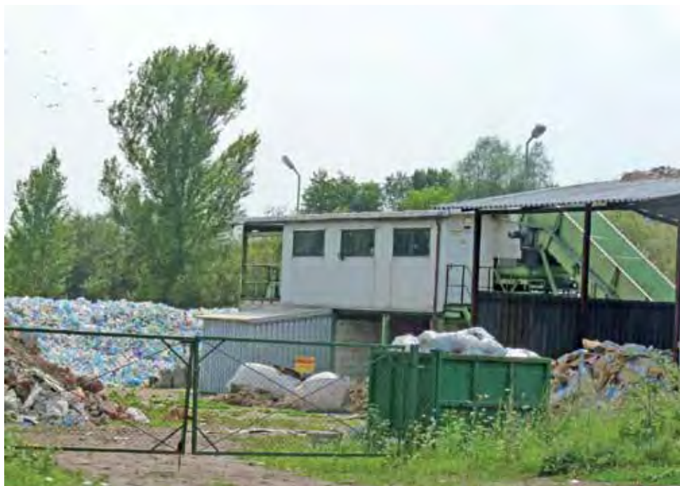
Segregatornia odpadów na składowisku uruchamiana jest tylko doraźnie.
