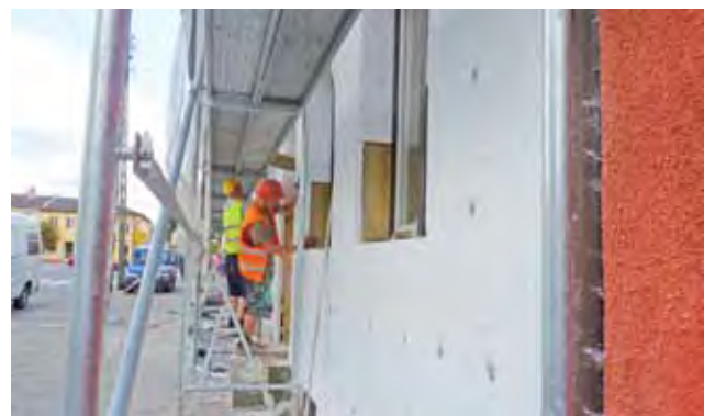
W centrum miasta na frontach pięciu kamienic będzie nowa elewacja. Jednocześnie ściana jest docieplona 5-centymetrową warstwą styropianu. Pracę wykonują pracownicy SZym-Budu z Żychlina.
