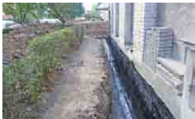
Ściany odkopano głęboko, by izolacja była skuteczna.
