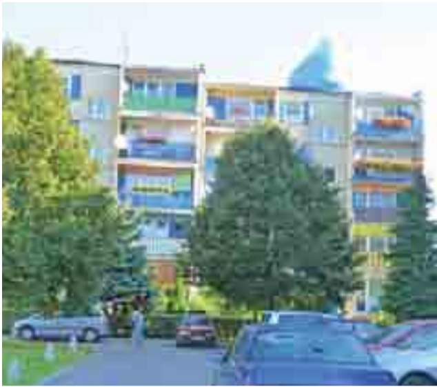
Mieszkańcy żartują, że na dachu wylądowało ufo. Tymczasem jest to zabezpieczenie dla pracujących pracowników.
