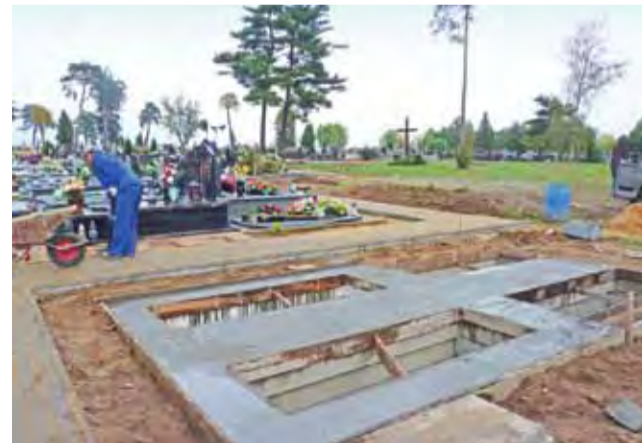
Aleiki na nowej części cmentarza zostały zrobione. Teraz trwa budowanie piwnic grobowych wzdłuż alejek.
