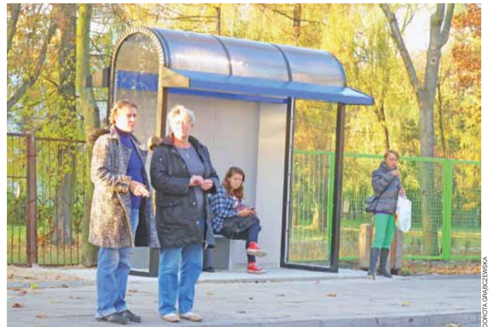
Stare, blaszane wiaty przystankowe, zastąpiono nowymi, przeszklonymi.
