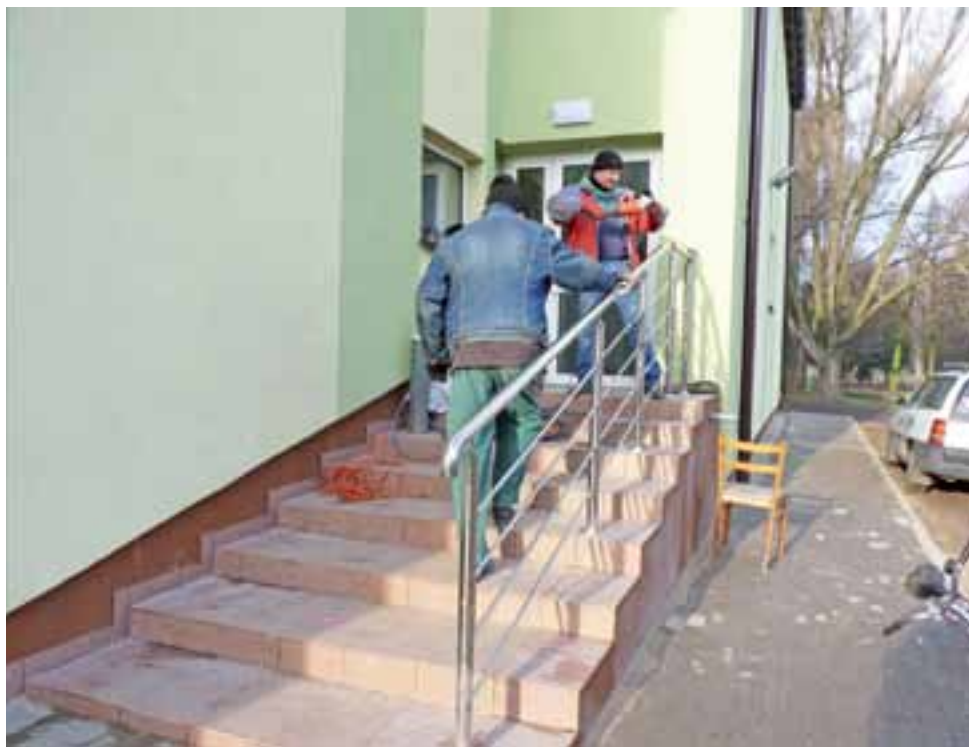
10 grudnia pracownicy firmy Elvis kończyli robienie barierki przed wejściem do pomieszczeń biurowych.
