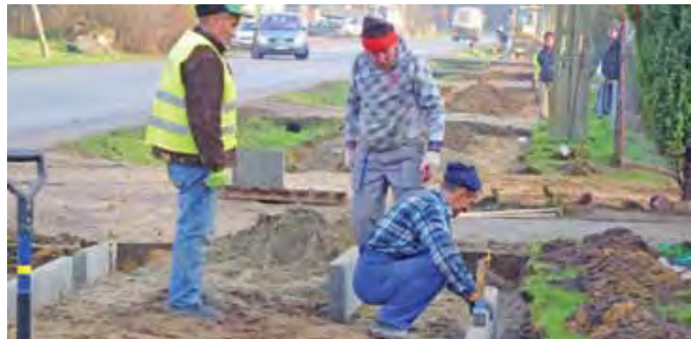
Centrum Oporowa rozkopane. Trwa układanie nowego chodnika z kostki polbrukowej o szerokości 2,5 metra, od biblioteki do zamku. Prace wykonują pracownicy firmy Elvis z Żychlina.
