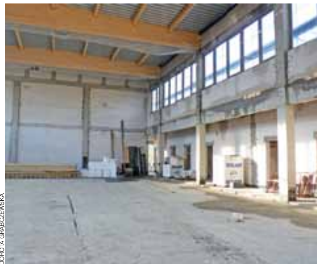
Tak wygląda sala gimnastyczna od środka. Duża przestrzeń już cieszy.
