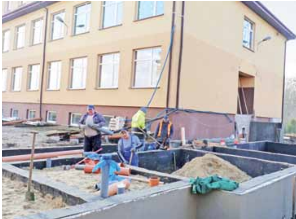
Gostyniński Hydropol buduje teraz łącznik pomiędzy salą gimnastyczną a Zespołem Szkół. Do końca sierpnia 2015 roku inwestycja ma być zakończona.
