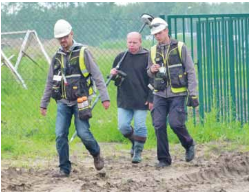
W ubiegły czwartek na terenie rozbudowy zakładu przy ul. Podlipie obecni byli m.in. geodeci ze zgierskiego Geoplanu.
