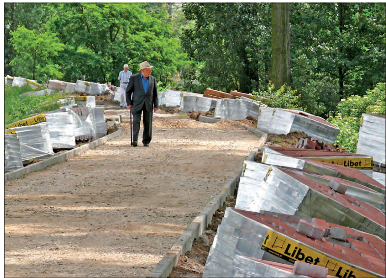
Kostka już zgromadzona, prace trwają.
