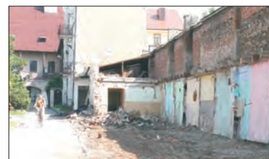
Po kilku dniach prac budynek zniknął.
