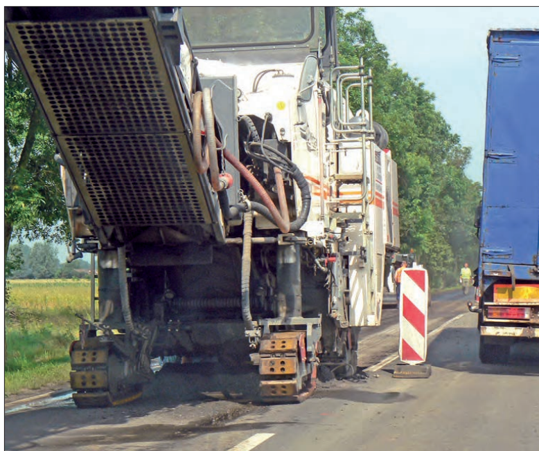
Utrudnienia na drodze do Skierniewic. Warszawski Mostostal rozpoczął już na dobre remont drogi krajowej nr 70 na odcinku od Nieborowa do Skierniewic. Aktualnie utrudnienia są w pobliżu skrzyżowania z drogą do Michałówka w gminie Nieborów oraz w okolicach Mokrej Prawej w powiecie skierniewickim.
