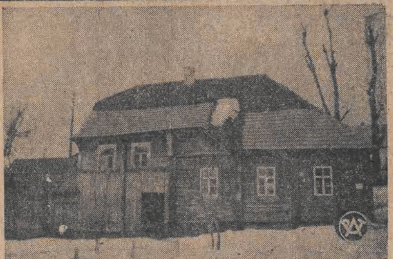
Piękny okaz polskiego zabytku budownictwa drewnianego — szkoła w Nowogrodku o oryginalnej konstrukcji dachu.
