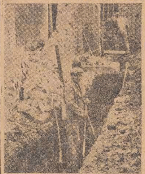
Pospieszenie przeprowadza się kanalizację na terenie PZPB Nr 3
