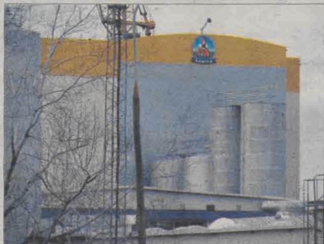
Kolorowy, nowy budynek, mieszczący unikalną instalację, widać również z ul. Poznańskiej.
