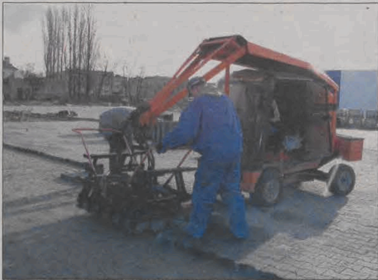
Budynek Tesco już stoi, teraz trwają prace przy podłączaniu kanałów odpływowych z parkingu i układaniu kostki.
