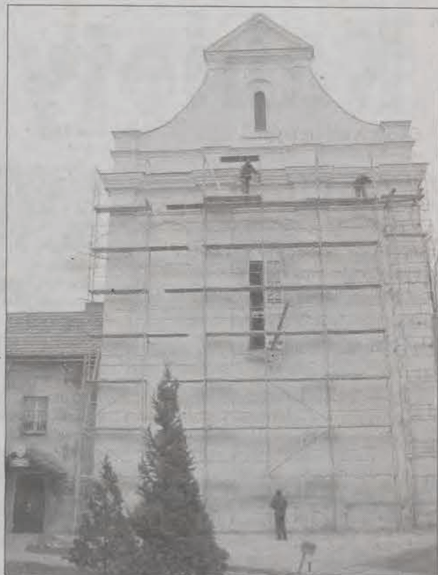
W minionym roku odnowiono elewację szczytowej części budynku. Na ten rok zaplanowano kolejne prace.
