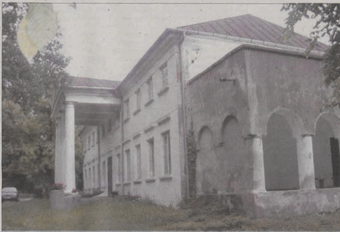
Remont elewacji pałacu w Mrodzie jest niezbędny.
