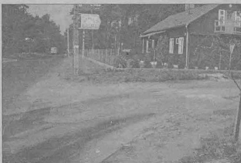
Zniszczony przez ponad 50 tonowe samochody wjazd na ul. Piaskową
