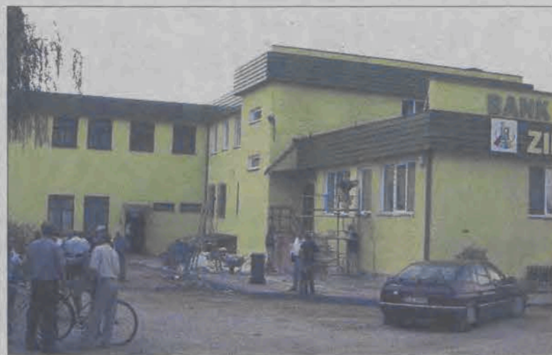
Jednolita nowa elewacja banku i ośrodka kultury w Domaniewicach jest bardzo charakterystyczna i widoczna z daleka.
