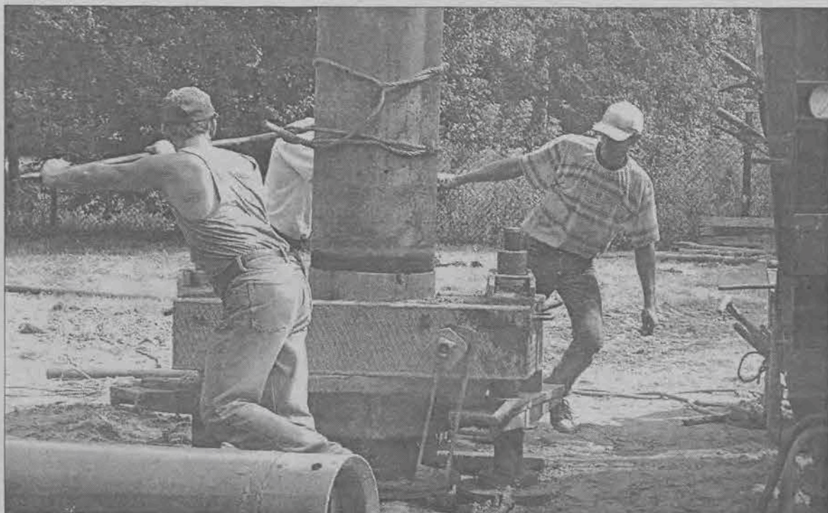
Robotnicy skręcają kolejny odcinek rury w czasie dokonywania odwiertu. Po uruchomieniu, ze studni będzie można pozyskać 70 m³ wody na godzinę.
