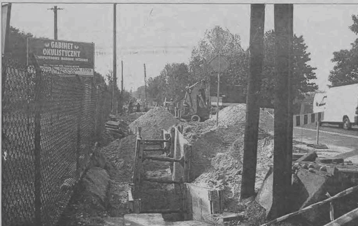
Te potężne wykopy świadczą o tym, że prace prowadzone na drodze krajowej nr 14 to ogromna inwestycja.
