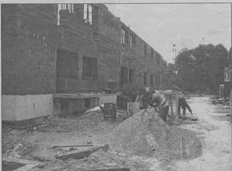
Budowa internatu w Dobieszkowie
