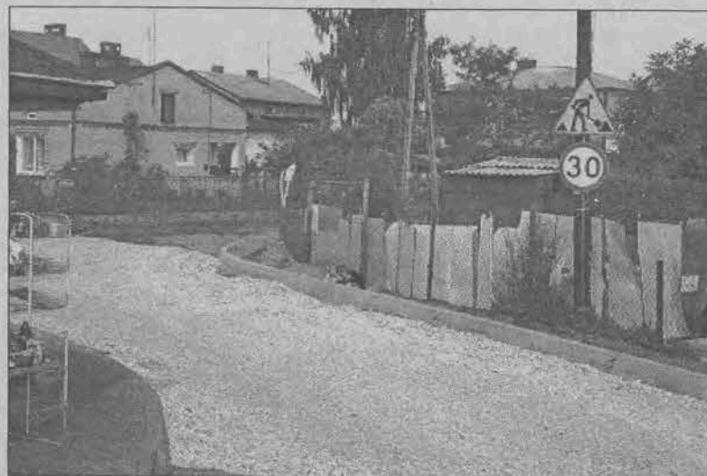
Ku końcowi zbliża się kładzenie asfaltu na ulicy Zagórskiej na Górkach w Łowiczu. Przedsiębiorstwo Robót Inżynieryjno - Drogowych, które wygrało przetarg nieograniczony na te prace, położy asfalt o długości ponad 800 metrów. (mak)
