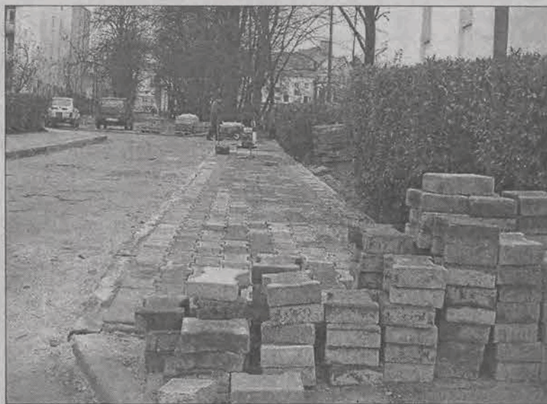
Kostka na Broniewskiego. Na wniosek mieszkańców bloku nr 2 na osiedlu Broniewskiego Łowicka Spółdzielnia Mieszkaniowa zleciła ułożenie betonowej kostki przed blokiem, od strony osiedla oraz utwardzenie dojeżdżających do kontenerów na śmieci. Prace mają zostać zakończone w pierwszym tygodniu listopada tego roku. Prowadzi je własna brygada remontowo-budowlana spółdzielni. (mak)
