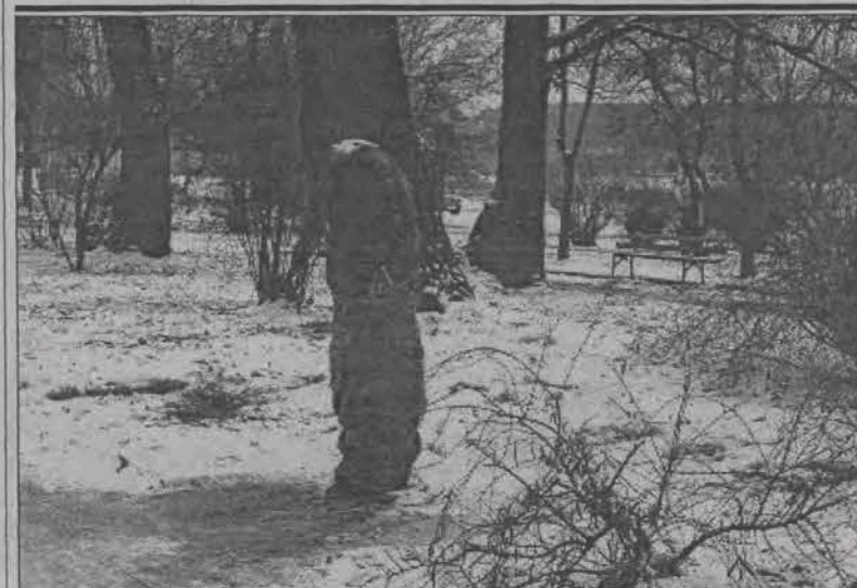
Zimowe ubranka miejskich hydrantów. Zimowa aura wprowadza konieczność wdziania grubych ubrań, ba - nawet kożuchów i futer. Nie dziwny się, że miejskie hydranty zostały odpowiednio do panującej pogody „ubrane”. Słomiane okrycie i folia je otulająca, umożliwiają mieszkańcom Głowna korzystanie z ogólnodostępnych ujęć wody w mroźne dni.
