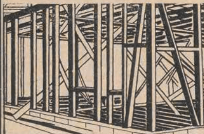
Riegelwerk (Skelett) des z. bauenden Hauses.
