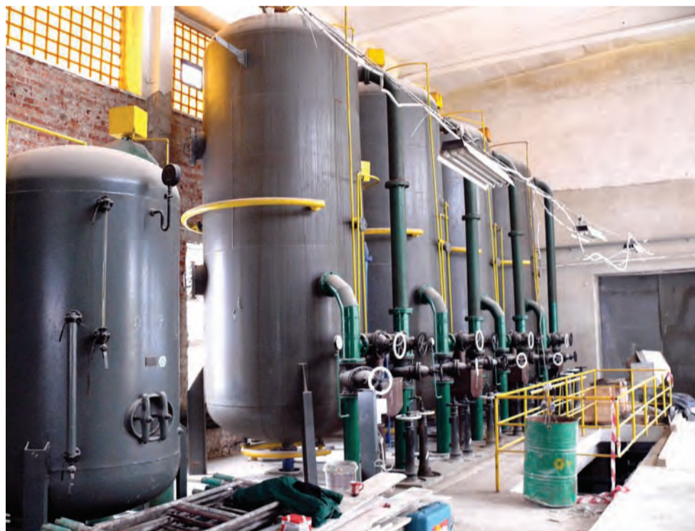
Stare zbiorniki filtrów w budynku stacji uzdatniania wody.
