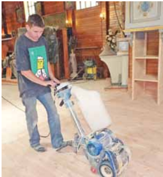
Ostatnie szlify. Ekipa górali już wkrótce zakończy remont modrzewiowej podłogi.
