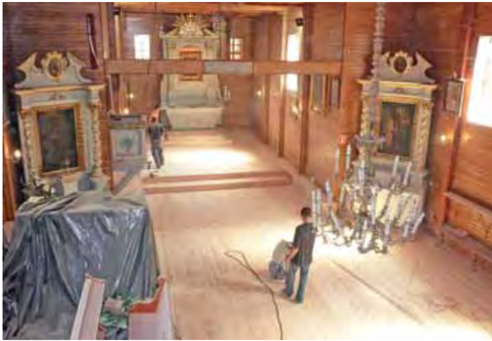
Ostatnie dni remontu. Modrzewiowa podłoga jest już niemalże gotowa.
