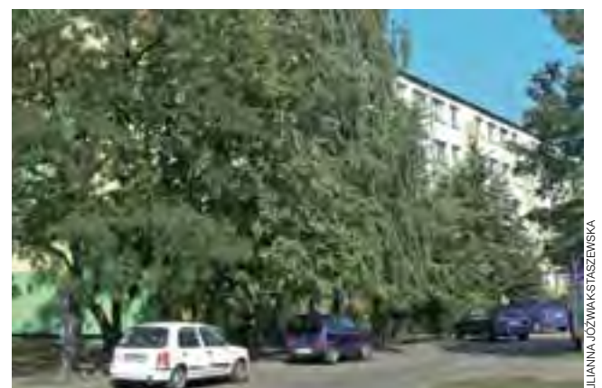
Bloki na Kopernika: gdyby pod oknami nie było krzewów, chłopiec pewnie już by nie żył.
