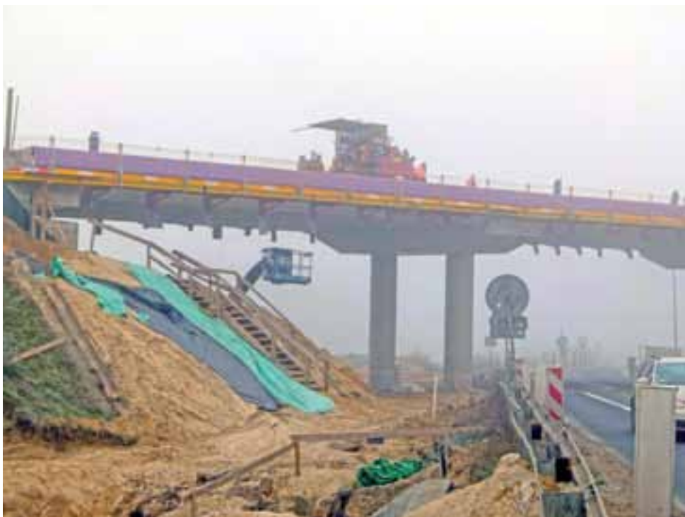
Węzeł Tuszyn, czyli końcówka III odcinka A-1. Zaangażowanie robotników i maszyn największe na całej budowie.
