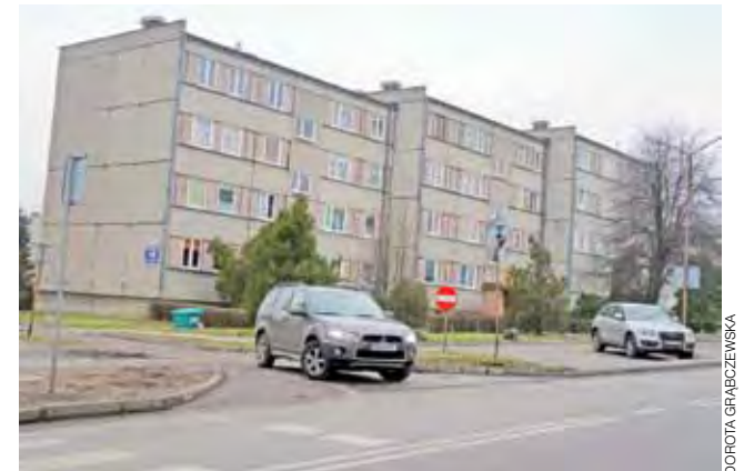
Mieszkańcy bloku Traugutta 14 nie są zainteresowani dociepleniem bloku. Tak więc blok zostanie szary, tak jak szare jest całe miasto.
