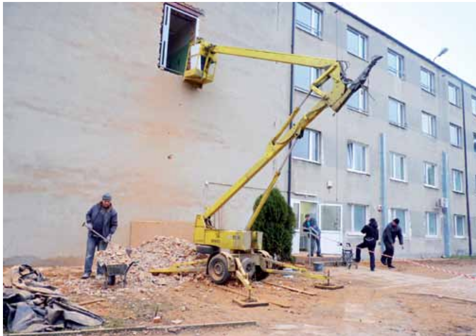
Trwa budowanie windy dla niepełnosprawnych w budynku dawnej „Nadziei”. MOS sprowadzi się na dobre 1 września, ale z windy jako pierwsi będą korzystać podopieczni Warsztatów Terapii Zajęciowej.
