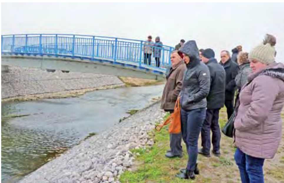
O budowie takiego betonowo-stalowego mostu, jak ten pod Łowiczem, myśli wójt Krzysztof Kołach.
