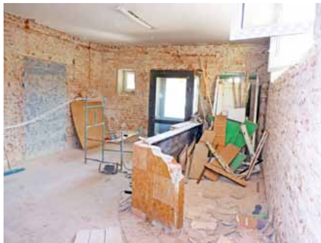
Trwa adaptacja pomieszczeń administracyjnych w dawnym budynku kina Lech. Zerwano drewnianą boazerię oraz skuto stare tynki. Do końca czerwca wnętrze ma być jak nowe.
