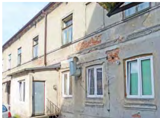
To w tej oficynie, na I piętrze mieszkał Wincenty Jagielski. Ponieważ do niedawna nie było dostępu do tego lokalu, pozostały w nim stare okna.
