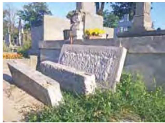
Grobowiec Lilienheima czeka na naprawę po zniszczeniu przez nawalnicę sprzed kilku tygodni.
